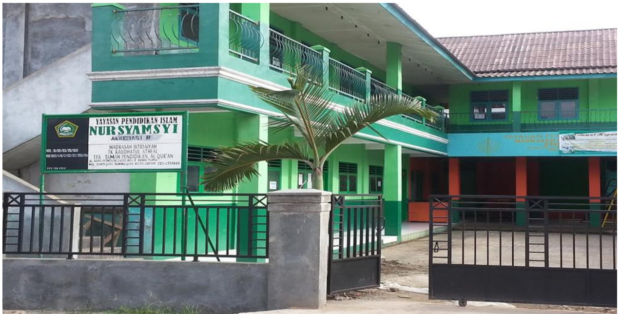
Gambar 1.3 Gedung Sekolah SMPI Nursyamsi Pondok Duta Depok
