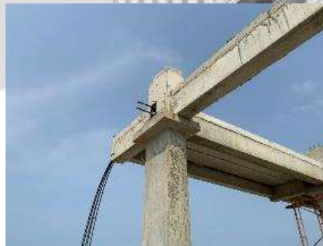
Kolom, balok, hollow core, sambungan paskatarik tanpa lekatan
